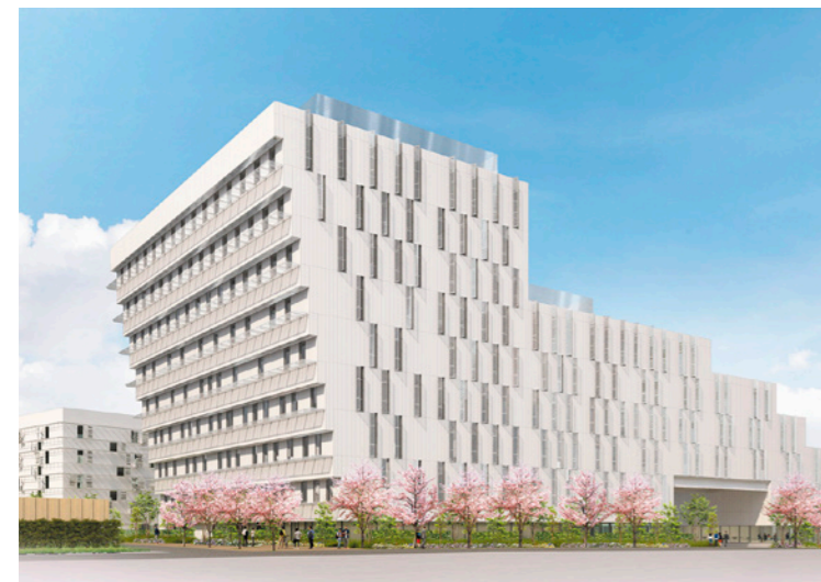
2021年竣工の新校舎完成予想図 パース図提供：東洋大学赤羽台キャンパス設計監理共同企業体(隈研吾建築都市設計事務所・日本設計・戸田建設)
