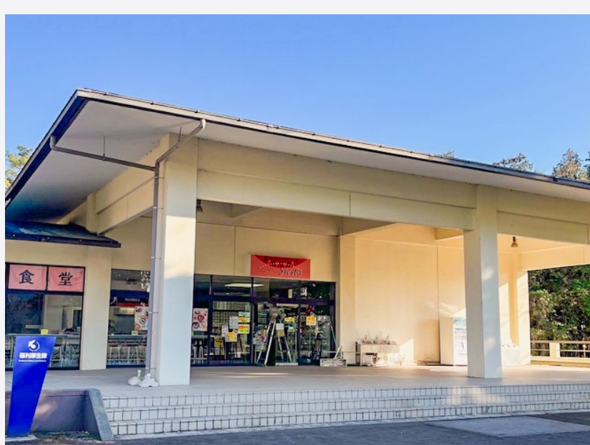
福利厚生棟食堂
