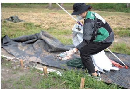
国境「メディカ」 避難民滞在施設の撤去作業
