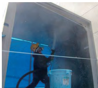
図-2 吹付け養生施工状況
