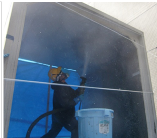
図-2 吹付け養生施工状況
