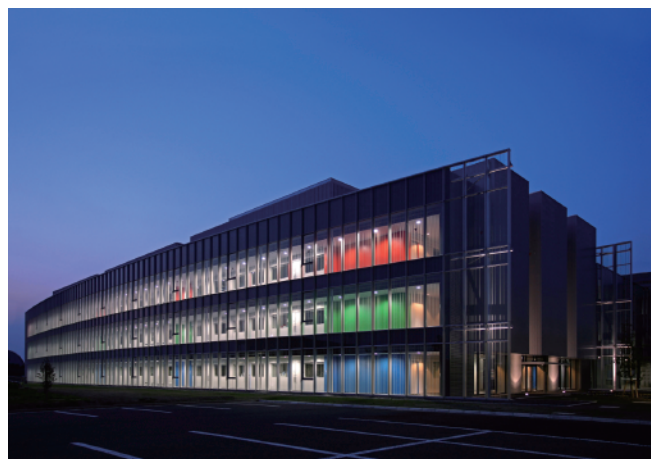
板倉キャンパス5号館研究棟
