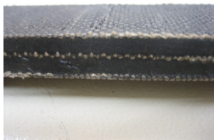
写真① 積層ゴム
