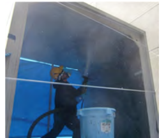
図-2 吹付け養生施工状況
