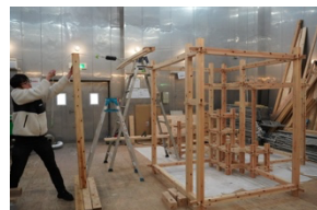
写真 9：人力载荷試験の様子
