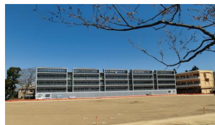
新校舎南館の全景
