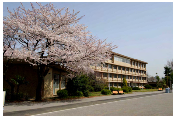
講義棟（A 棟）全景
