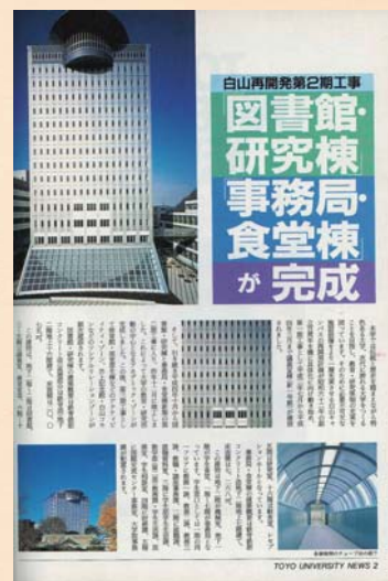
1995(平成7)年2月27日/第136号 白山再開発の第2期工事が1994(平成6)年12月に竣工し、「図書館・研究棟」「事務局・食堂棟」が完成したことを報告
