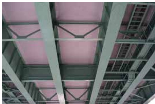
シートによる補強面(仕上げ塗装後)
