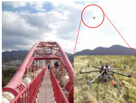
写真-3 マルチコプターによる点検
