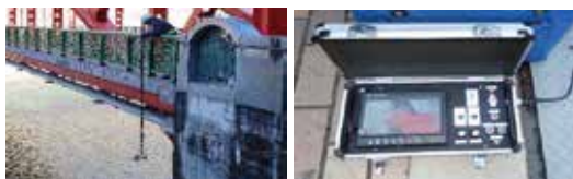
写真-1 ポールカメラによる点検
