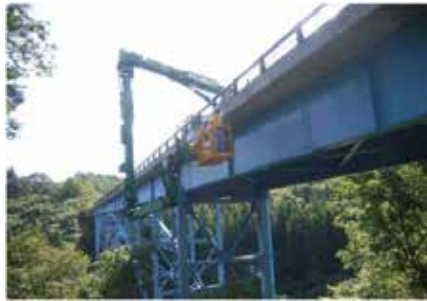
写-1 橋梁点検車による点検状況
