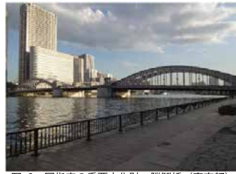
写-2 国指定の重要文化財 勝鬨橋（東京都）
