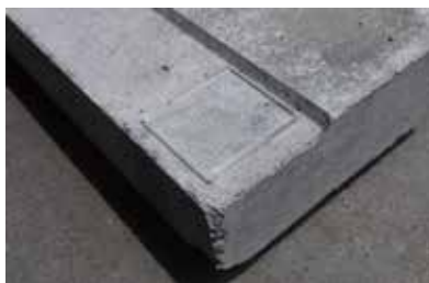
■ 貼り付け状況
