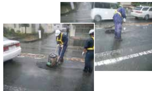
■ 「マイルドパッチ」施工状況（雨天時）
