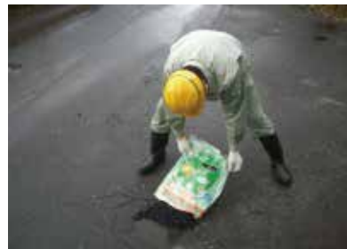
■ 「マイルドパッチ」施工状況
