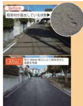
■ 路面のリフレッシュ（生活道路）
