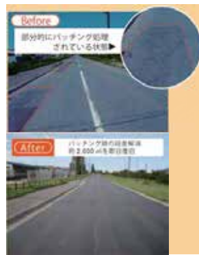
■ パッチング、ひび割れの補修（幹線道路）
