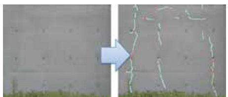
専用ソフトによるコンクリートひび割れ抽出
