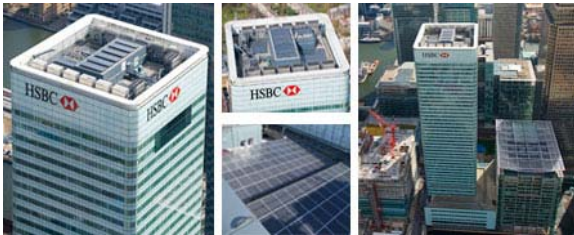
422枚の太陽光発電パネルを設置するHSBCロンドン国際本部ビル 出典: http://www.sharpmmanufacturing.co.uk/
