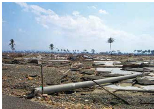
インド洋大津波災害（2004年12月）により被災した直後のバンダアチェ市海岸部ここには多くの住宅が立ち並んでいたが、津波によりほぼ壊滅。（2005年1月、筆者撮影）
