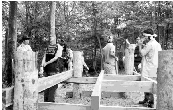
写真2 住民による施工風景
