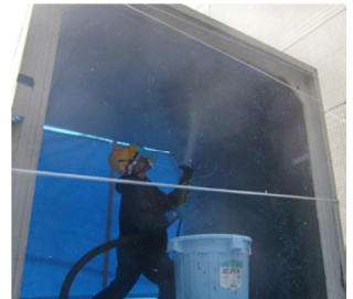
図-2 吹付け養生施工状況
