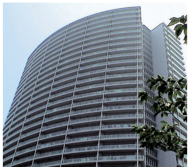
当社施工事例
