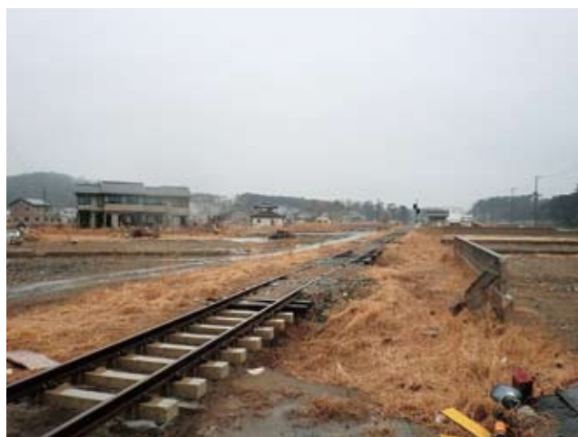
東松島市野蒜地区 鉄道（仙石線野蒜駅付近）が津波により大きく破壊されている。背後の建物も1階は津波で破壊されているがRC造のため建築物としては残っている。
