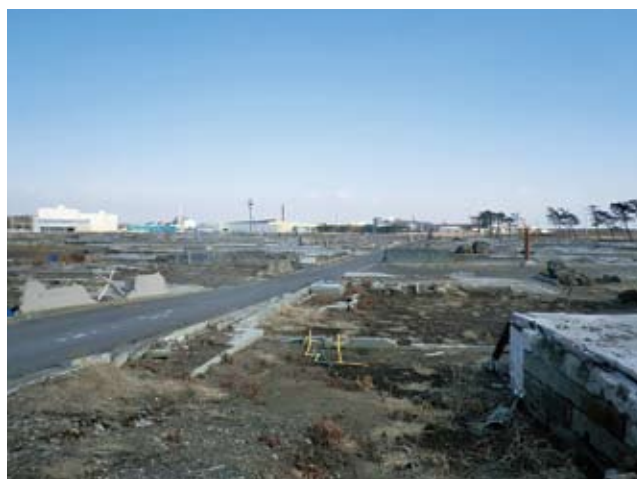
仙台市仙台港背後地 津波により市街地の建築物が流されて基礎だけが残っている。背後に見える建物（倉庫）はRC造のため建築物としては残り復旧されている。
