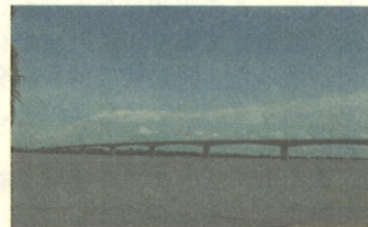
写真2 メコン川にかかる「絆橋」
