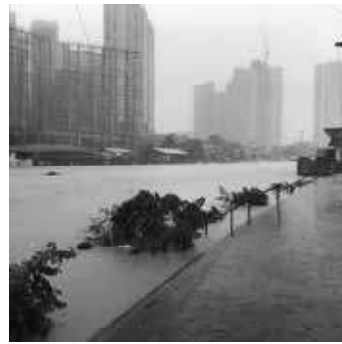
2020年11月の台風ユリシーズで被災したマニラ市内。1988年に日本支援により完成したマンガハン放水路や数次にわたる河川改修事業によって氾濫を最小限にいとどめた（JICAフィリピン事務所提供）。
