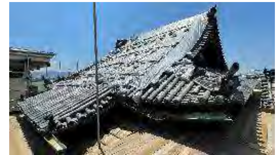
築350年前お堂の改修現場から土を採取
